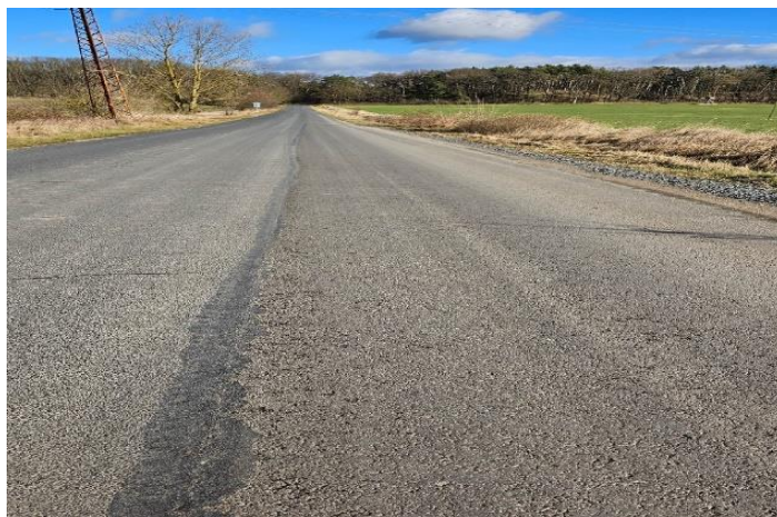
Fot. Droga powiatowa nr 1252F w miejscowości Świecko
