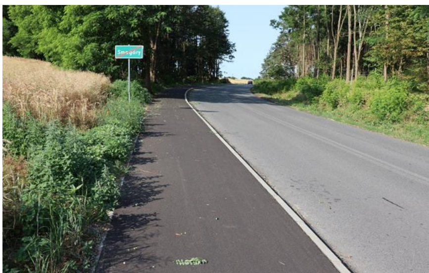
Fot. Wybudowany chodnik w m. Smogóry, fot. W. Obremski
