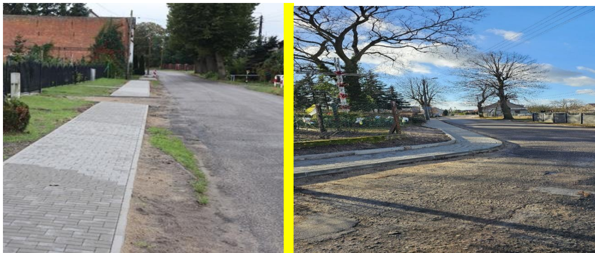
Fot. Wybudowany chodnik w m. Lisów, fot. W. Obremski
