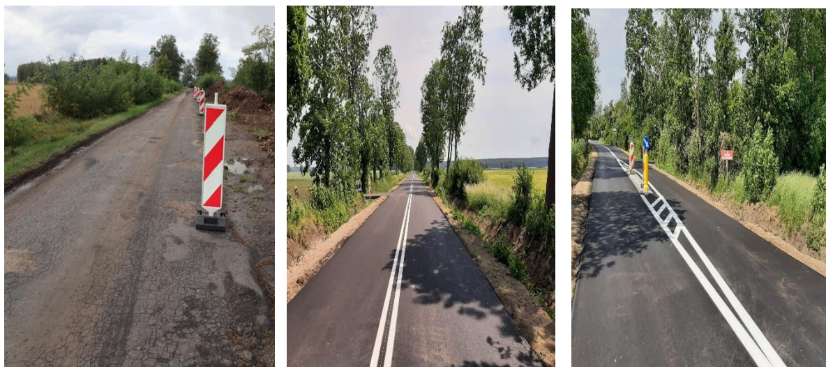
Fot. Remontowany odcinek drogi Cybinka – Kłopot - przed i po remoncie
