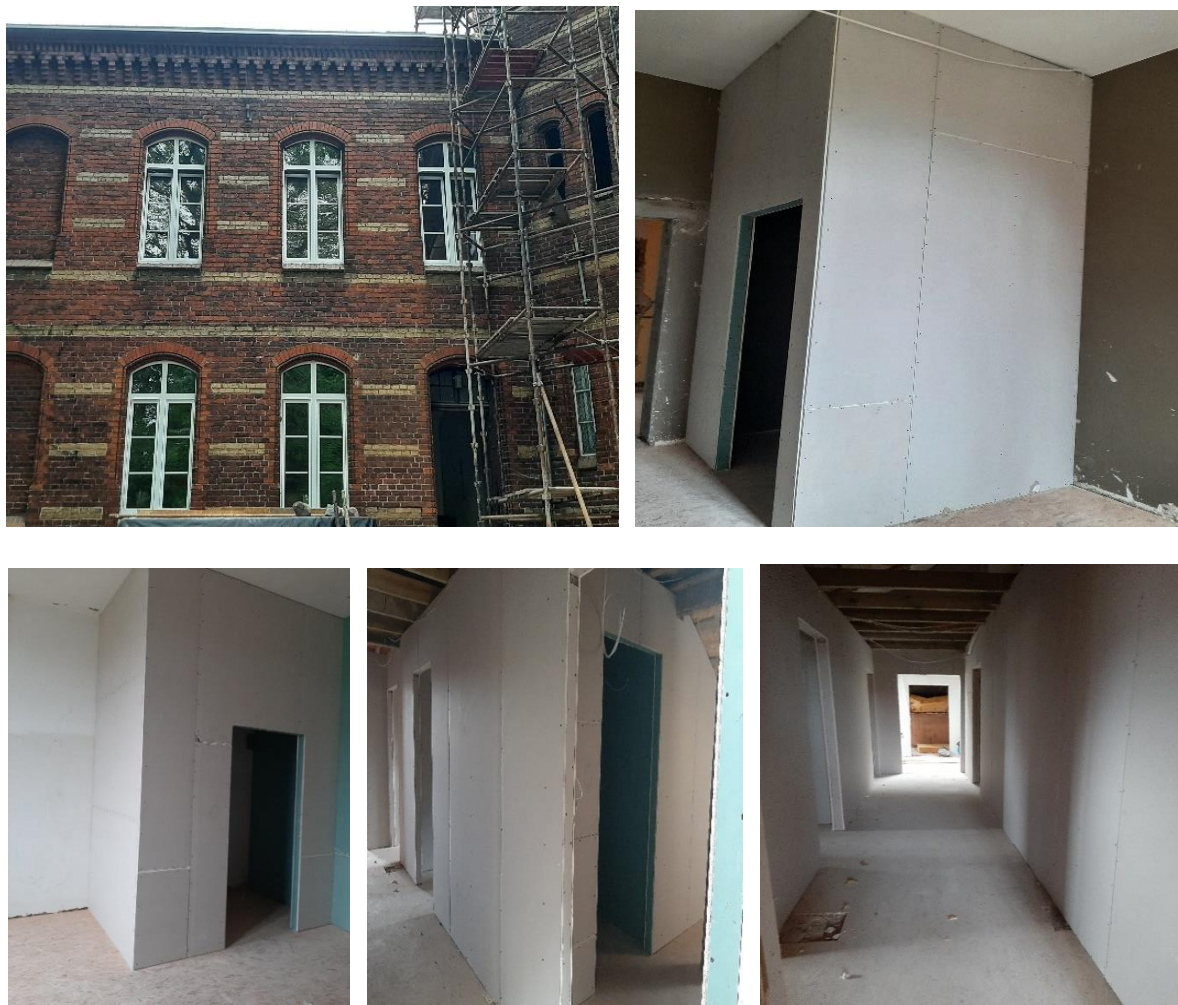
Fot. Skrzydło MOS w Ośnie Lubuskim – w trakcie remontu
