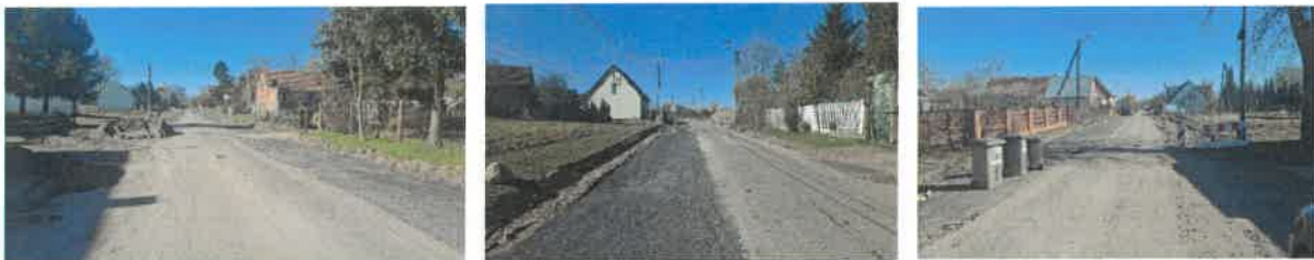
Fot. Droga powiatowa na odcinku Sienno-Ośno Lubuskie – przed przebudową oraz w trakcie robót budowlanych.
