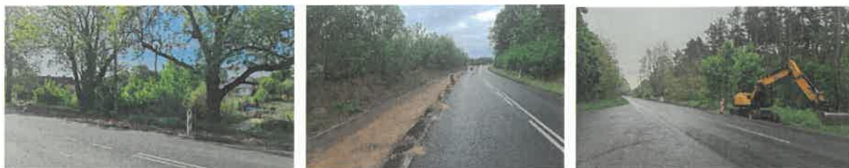
Fot. Budowa ścieżki rowerowej Gajec - Rzepin – zdjęcia przed rozpoczęciem budowy oraz w trakcie robót budowlanych.
