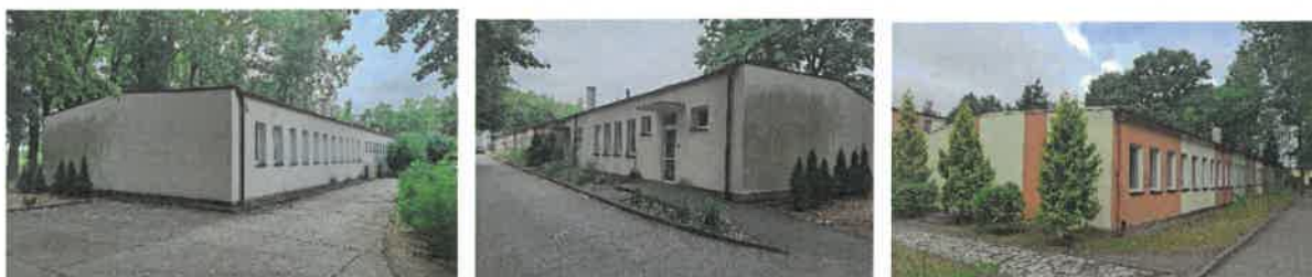
Fot. Obiekt szkolny przed podjęciem robót remontowych dachu budynku.
