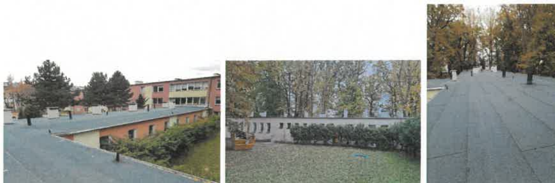
Fot. Obiekt szkolny po zrealizowanym remoncie dachu budynku.
