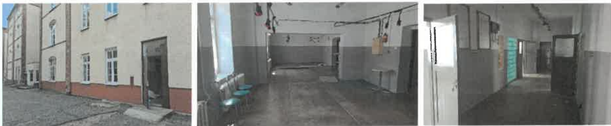
Fot. Parter szkoły ZSL przed rozpoczęciem robót budowlanych.
