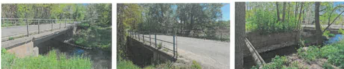
Fot. Obiekt mostowy przed podjęciem robót remontowych.
