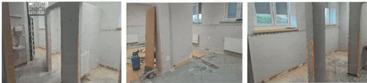
Fot. Pomieszczenia Działu Fizjoterapii w trakcie robót remontowych.
