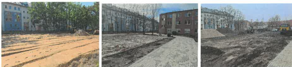
Fot. Boisko CKZiU w trakcie wykonywanej inwestycji.
