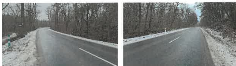
Fot. Droga powiatowa na odcinku Sienno-Ośno Lubuskie – po zakończeniu robót budowlanych.
