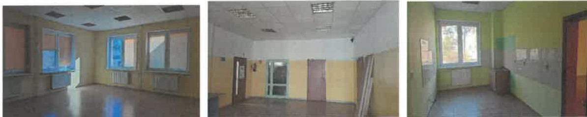
Fot. Przebudowa części budynku na POZ w Cybince - zdjęcia przed rozpoczęciem robót budowlanych.
