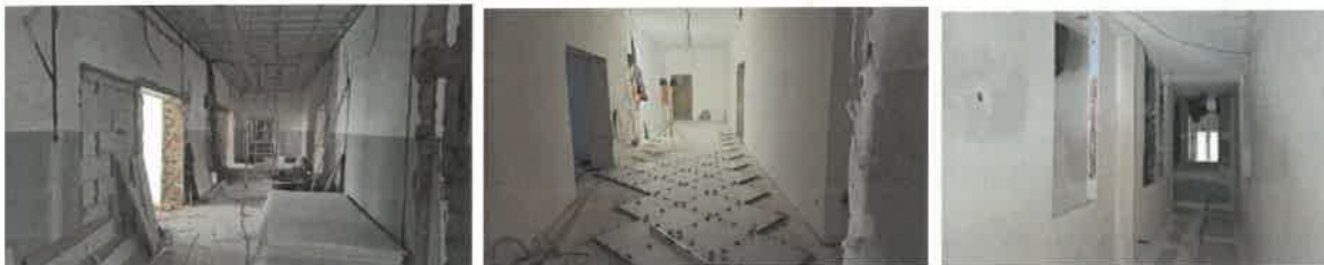
Fot. Parter szkoły ZSL w trakcie wykonywanych robót budowlanych.
