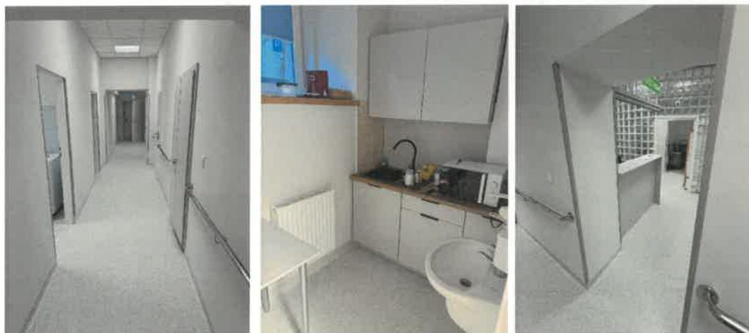
Fot. Pomieszczenia Działu Fizjoterapii po wykonaniu robót remontowych.
