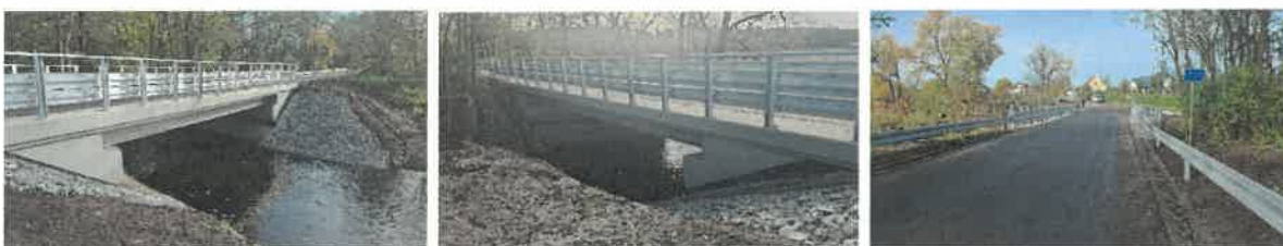
Fot. Obiekt mostowy po wykonaniu robót remontowych.
