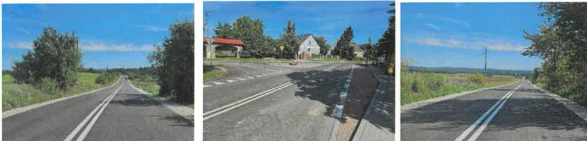
Fot. Droga powiatowa na odcinku Sienno-Ośno Lubuskie – po zakończeniu robót budowlanych.
