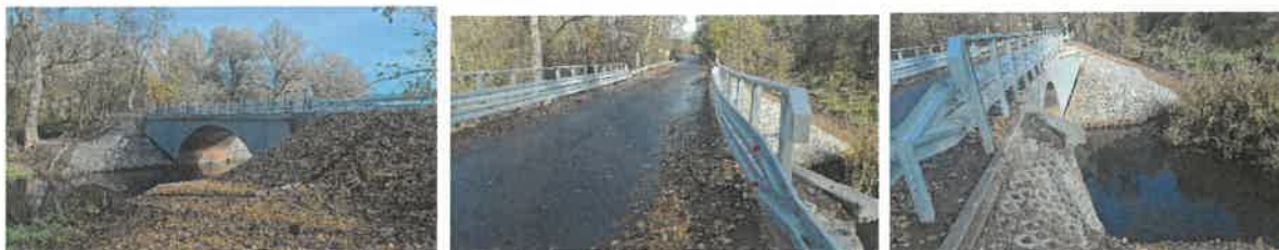
Fot. Obiekt mostowy po wykonaniu robót remontowych.
