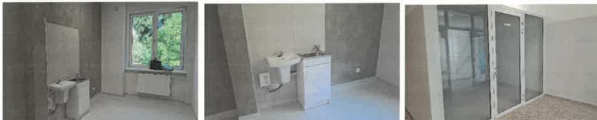
Fot. POZ w Cybince - zdjęcia po zakończeniu przebudowy.
