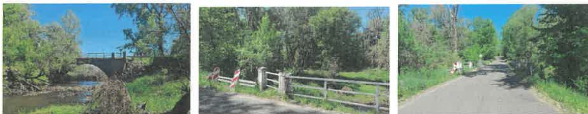
Fot. Obiekt mostowy przed podjęciem robót remontowych.
