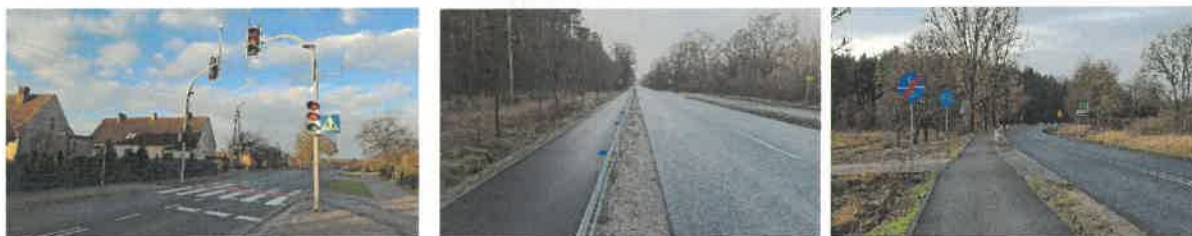
Fot. Budowa ścieżki rowerowej m. Gajec - Rzepin – zdjęcia po zakończeniu zadania.
